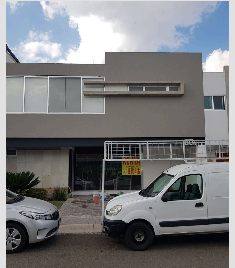
REPARACIONES EN CASA HABITACION, ZEN HOUSE
