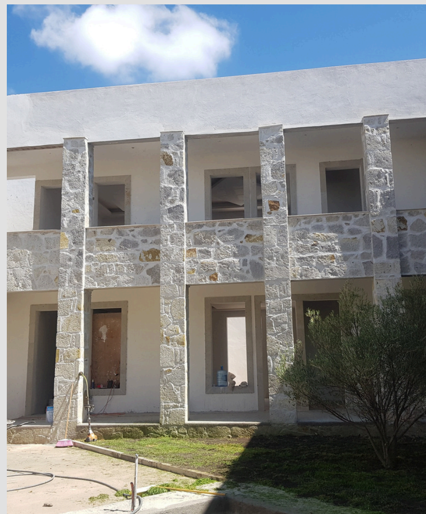
REPARACION Y DIRECCION DE OBRA EN PROCESO CONSTRUCTIVO , HOTEL BERNAL
