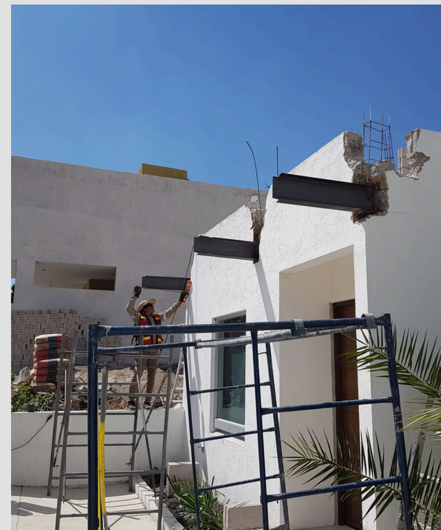
AMPLIACION DE SEUNDO PISO EN CASA HABITACION , EL REFUGIO
